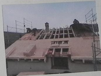
ALS NÄCHSTES DÄMMTEN WIR DIE ÄUSSEREN TEILE DES DACHS MIT 80 MM HOLZWOLLDÄMMUNG. ANSCHLIESSEND BEGANNEN WIR VON UNTEN NACH OBEN MIT DEM VERLEGEN DER WEICHFASERPLATTEN BIS CA. 30 CM UNTER DEM FIRST.
