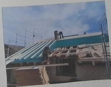
NACH DEM VERLEGEN DER WEICHFASERPLATE WAR DAS UNTERDACH AN DER REIHE. DIE BAHNEN MUSSTEN FÜR 100% DICHTIGKEIT MIT DEM HEISSLUFTFÖHN VERKLEBT WERDEN. ICH BEREITETE IN ZWISCHENZEIT DIE KONTERLATTEN MIT NAGELDICHTUNGEN VOR.
