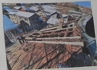
NACHDEM DAS DACH GEÖFFNET WAR WURDEN DIE NEUEN SPARREN EINGEPASST UND BEFESTIGT. ICH UND DER LEHRLING ERSTELLTEN DIE UNTERKONSTRUKTION FÜR DIE ZUSATZDÄMMUNG.
