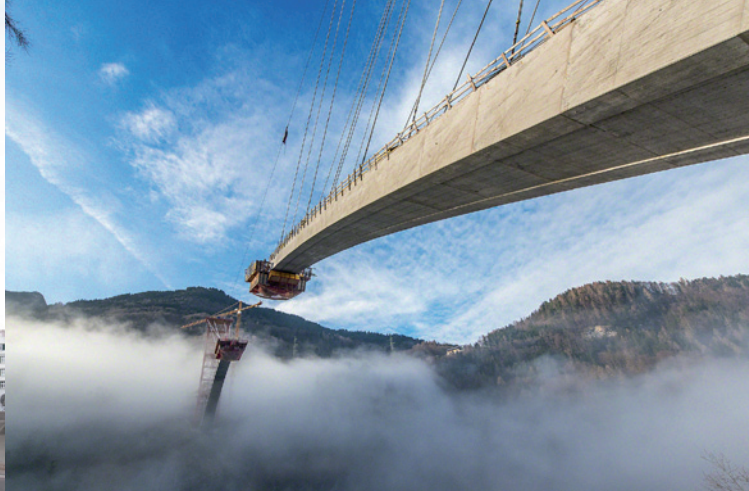
Tamina-Bogenbrücke; Foto: Rolf Enderes
